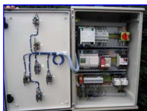
Cuadro de mando eléctrico
