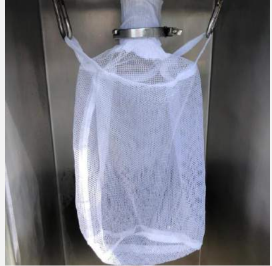
Foto 22: Se entregaron sacos a la PTAR y se realizaron los cambios de sacos.
