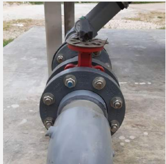
Foto 16: Cambio de brida en la línea del soplador 2.
