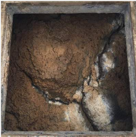
Foto 23: Trampas de grasas saturadas y en descomposición.
