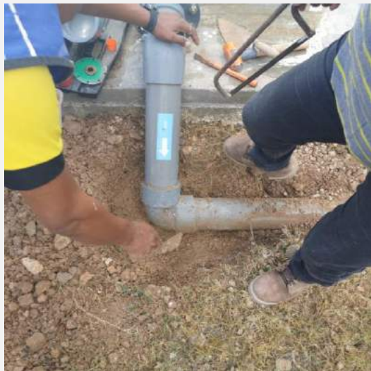
Foto 17 : Cambio de codo con fuga en la línea del soplador 2.
