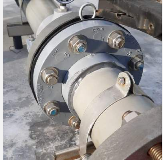
Foto 14: Cambio de brida en la línea del soplador 1.
