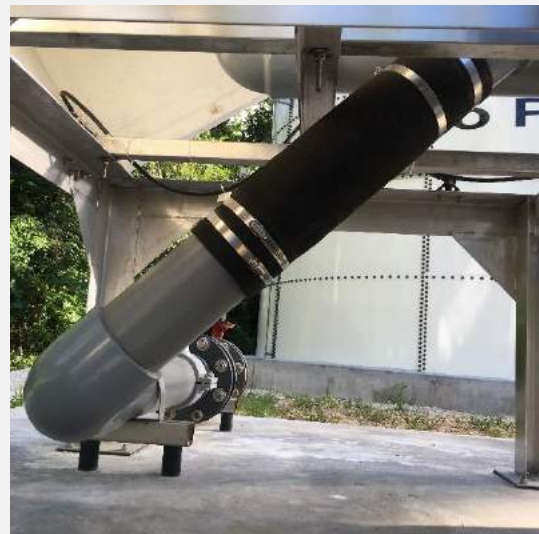
Foto 12: Ajuste de la base, abrazaderas y neopreno del soplador 1.
