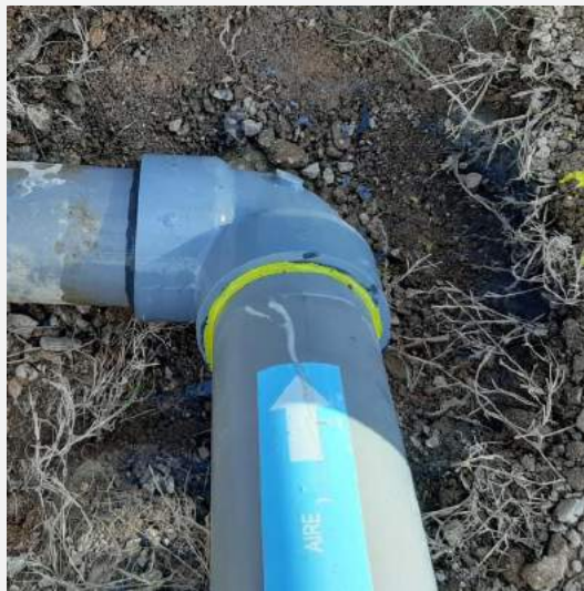
Foto 18: Se realizó el cambio de codo y su correcto sellado.
