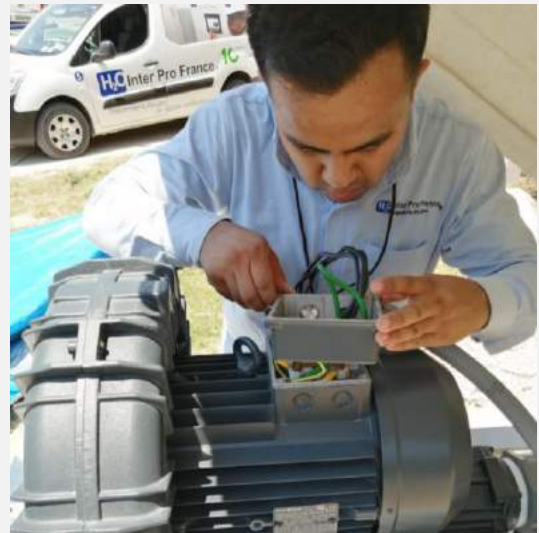
Foto 10: Reparación de soplador.
