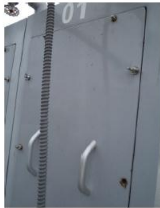
FOTOS 9 Y 10 - FALTA DE TORNILLOS Y TUERCAS EN SEPAR PRO 1 Y 3
