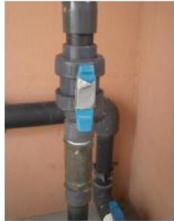
FOTO 7- VÁLVULA ESFERA ROTA (BOMBA DE FILTRACIÓN # 23)
