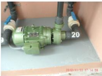
FOTO 15 - MANTENIMIENTO A BOMBAS DE FILTRACIÓN (APLICACIÓN DE PINTURA)
