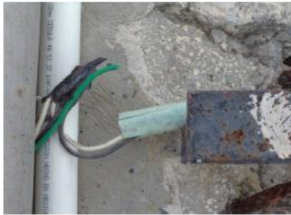
FOTOS 1 Y 2- EMPALMES ELÉCTRICOS SIN PROTECCIÓN.
