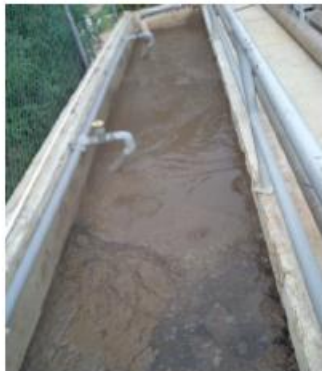
FOTO 3- DIFUSORES DE DIGESTOR 1 OBSTRUIDOS
