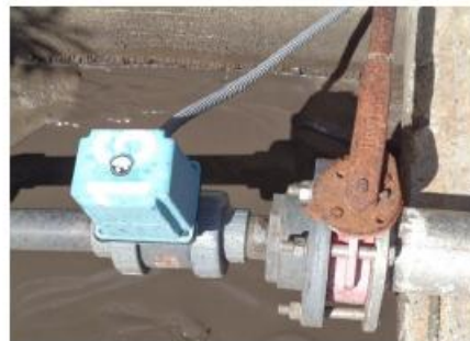
FOTOS 6 - VÁLVULAS DE MARIPOSA OXIDADAS (DIGESTORES)
