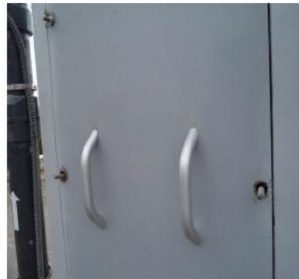
FOTOS 9 Y 10 - FALTA DE TORNILLOS Y TUERCAS EN SEPAR PRO 1 Y 3
