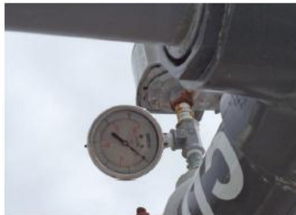
FOTOS 11 Y 12 - NO REGISTRAN PRESIÓN LOS MANÓMETROS DE LOS SEPAR PRO ®
