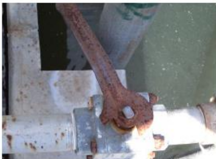
FOTOS 5 - VÁLVULAS DE BOLA OXIDADAS. (REACTOR 1)
