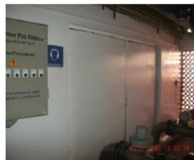
FOTO 16 - MANTENIMIENTO A CUARTO DE MÁQUINAS (APLICACIÓN DE PINTURA)
