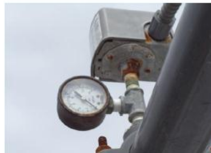
FOTOS 11 Y 12 - NO REGISTRAN PRESIÓN LOS MANÓMETROS DE LOS SEPAR PRO ®
