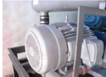
FOTO 8- MANTENIMIENTO DE SOPLADOR # 17 (APLICACIÓN DE PINTURA)
