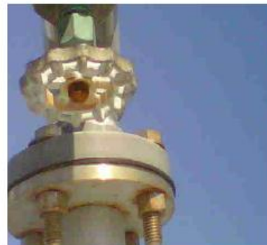
FOTO 4- VÁLVULAS DE COMPUERTA OXIDADAS (REGULACIÓN DE LOS SEPAR PRO®).
