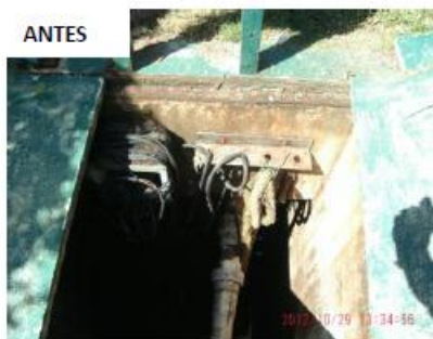
FOTOS 17 Y 18 - CÁRCAMO ESMERALDA, SE ELIMINÓ REGISTRO ELÉCTRICO Y SE INSTALARON CONECTORES GLÁNDULA A LOS ELECTRO-NIVELES.
