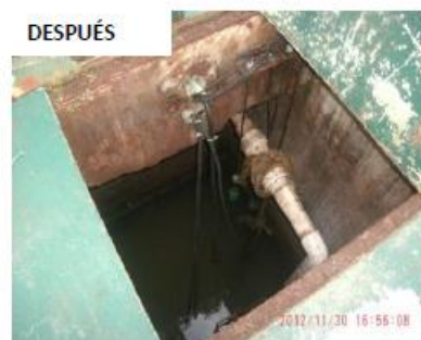
FOTOS 17 Y 18 - CÁRCAMO ESMERALDA, SE ELIMINÓ REGISTRO ELÉCTRICO Y SE INSTALARON CONECTORES GLÁNDULA A LOS ELECTRO-NIVELES.
